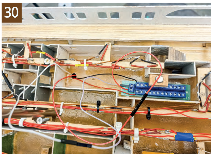
30 Zusätzlicher Stromverteiler im Deck
